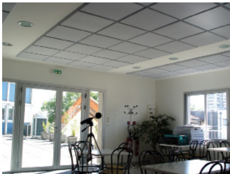
Réalisation d'un plafond absorbant pour une salle de restauration
